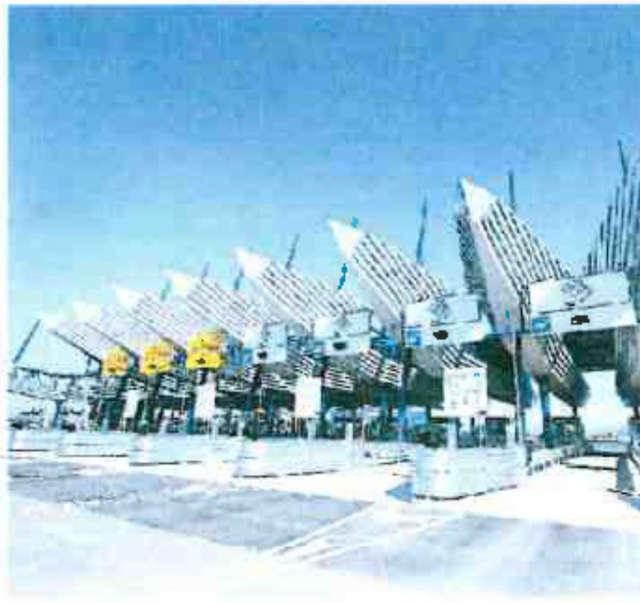
Il casello di Villesse: 300 tonnellate di carpenteria, lungo 135 metri
